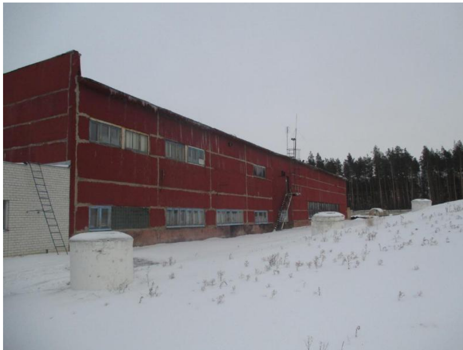
Общий вид комплекса станции 2-го подъема
